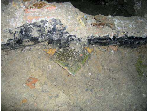
Afb. 17a-b Resten van plavuizenvloer 2C in het voorhuis van Hofstraat 15, diagonaal gelegd met gebruik van in vorm gemaakte driehoekige plavuizen
