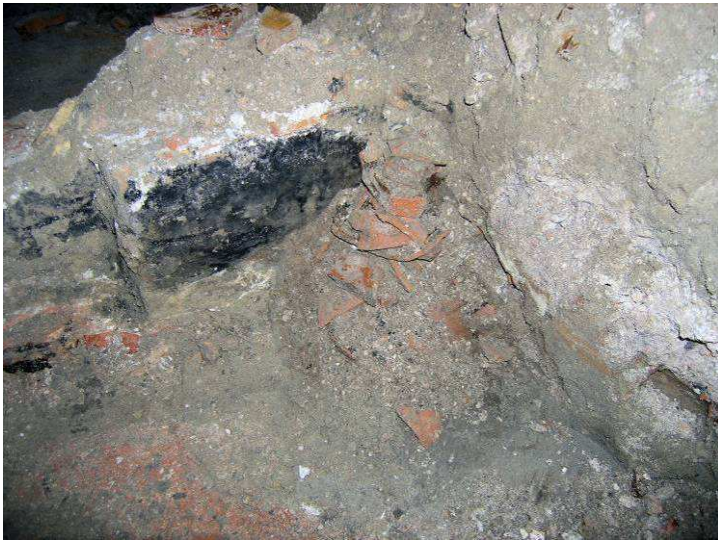
Afb. 17a-b Resten van plavuizenvloer 2C in het voorhuis van Hofstraat 15, diagonaal gelegd met gebruik van in vorm gemaakte driehoekige plavuizen
